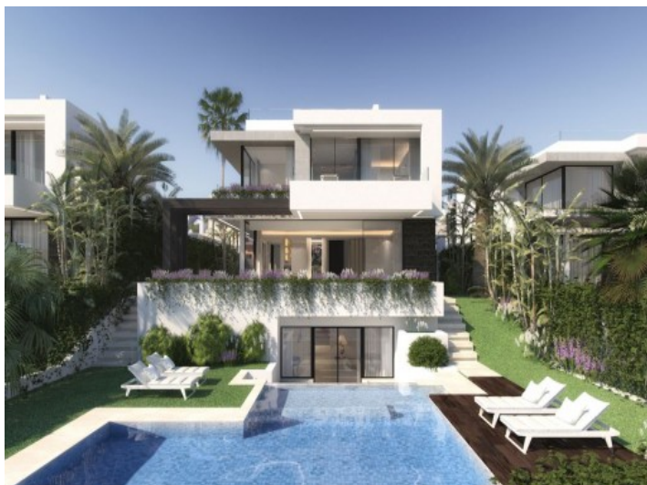
Vista exterior de la villa
